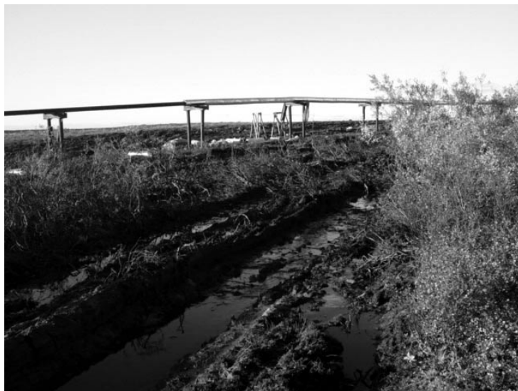
Строительство нефтепровода в Ненецком округе Следы летних работ на тундре сентябрь 2002 года
