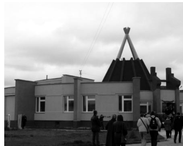
Отремонтированное здание Культурного центра с. Ловозеро, июнь 2003
